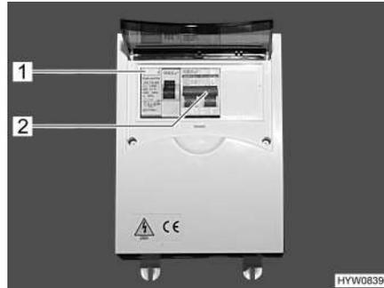
Fig. 62 Caja de fusibles de 230 V con interruptor de protección de línea e interruptor FI
